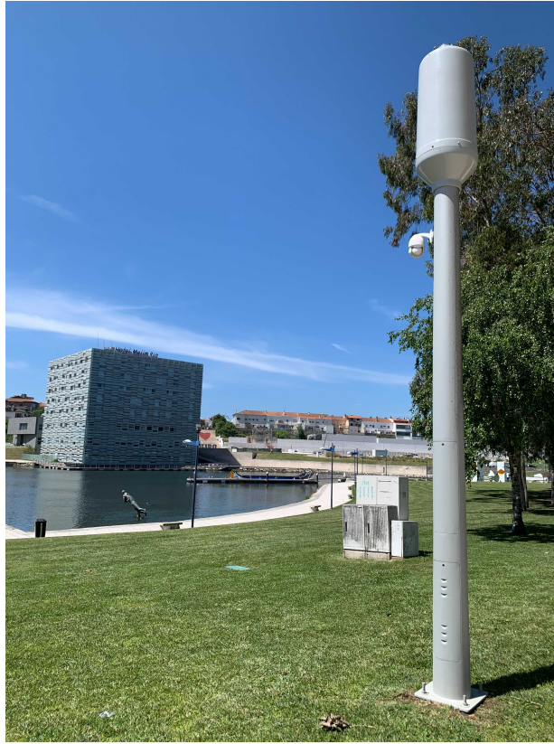
Figure 2: Smart Lamp Post in Cais da Fonte Nova
